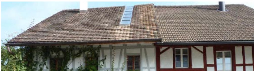
Unzulässig: vertikale Lichtbänder
